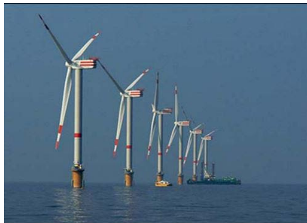
Thorntonbank Wind Turbines
