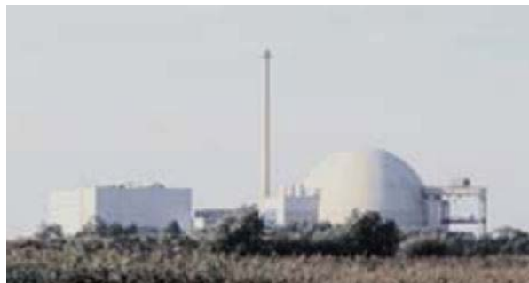
Unterweser (Esenshamm) Nuclear Power Plant
