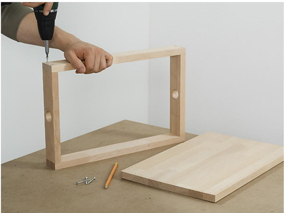
Позиционируйте боковины подноса относительно друг друга таким образом, как они должны соединяться между собой. Маркируйте карандашом контуры коротких боковин ящика на внутренних поверхностях длинных боковин; отметьте в центре по два отверстия, просверлите их и раззенкуйте снаружи. Теперь соедините боковины ящика-подноса с помощью аккумуляторного шуруповёрта и шурупов  $3,5 \times 40$  мм. При этом следуйте совету по резьбовому соединению двух деталей МДФ (см. описание шага 5).
