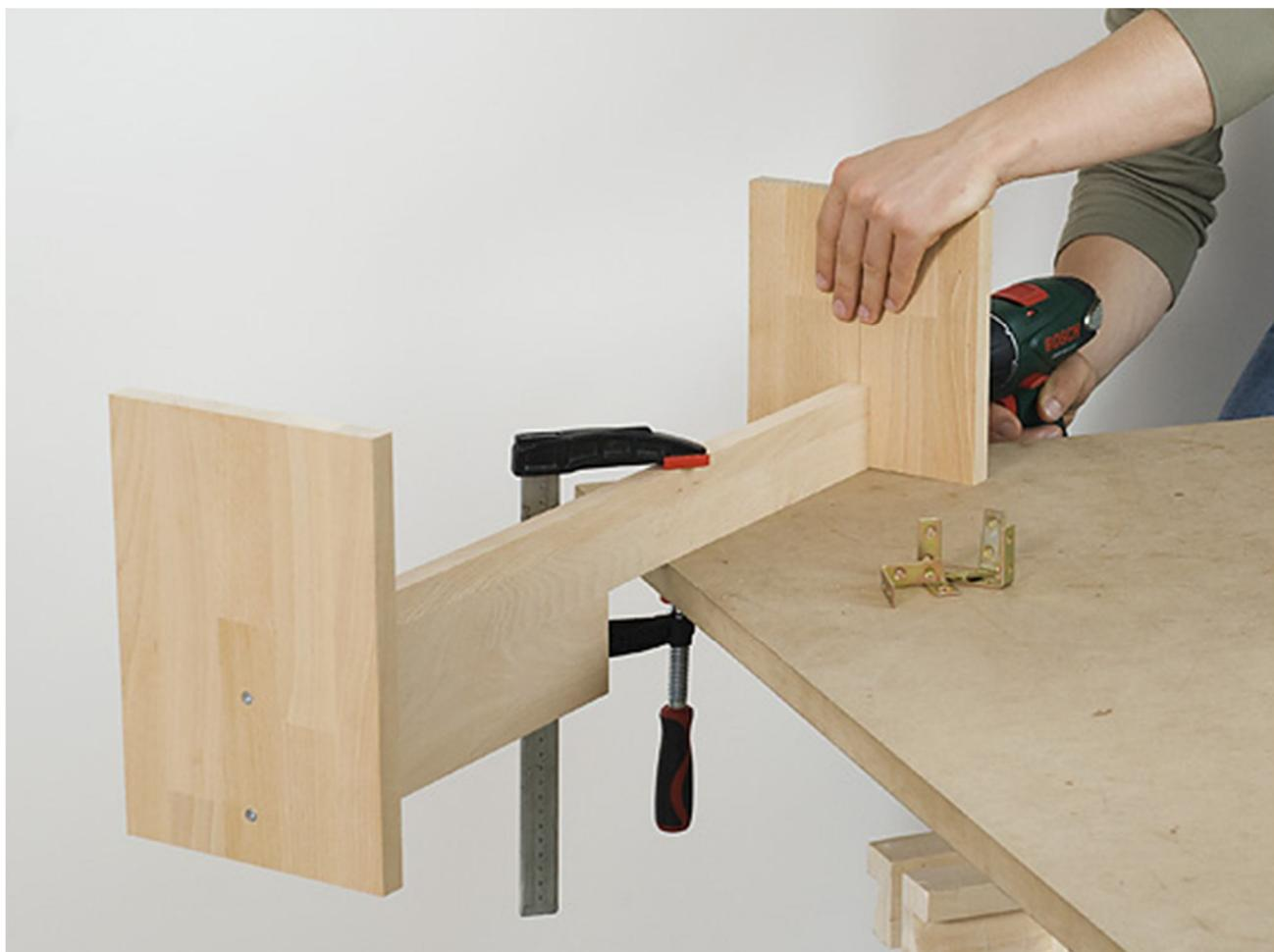
Для установки опор и поперечины сначала позиционируйте их относительно друг друга так, как они будут соединены между собой позднее. Отметьте карандашом контуры поперечины на поверхностях опор, направленных внутрь, и маркируйте по центру контуров по два отверстия. просверлите отверстия и раззенкуйте их снаружи. Приверните опору к поперечине с помощью аккумуляторного шуруповёрта и шурупов 4 x 60 мм.
