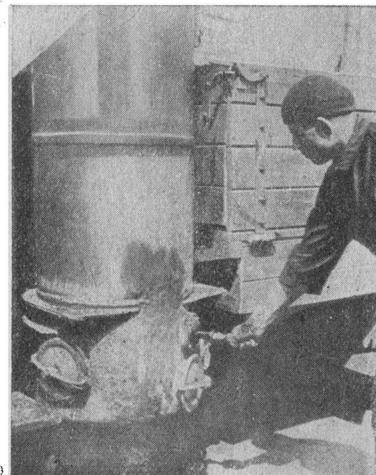
Рис. 27. Розжиг газогенератора.
