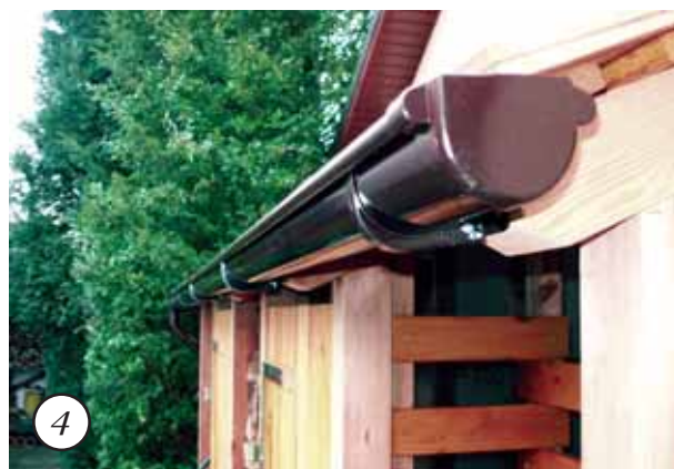
Концевой элемент просто вдвигается в желоб
