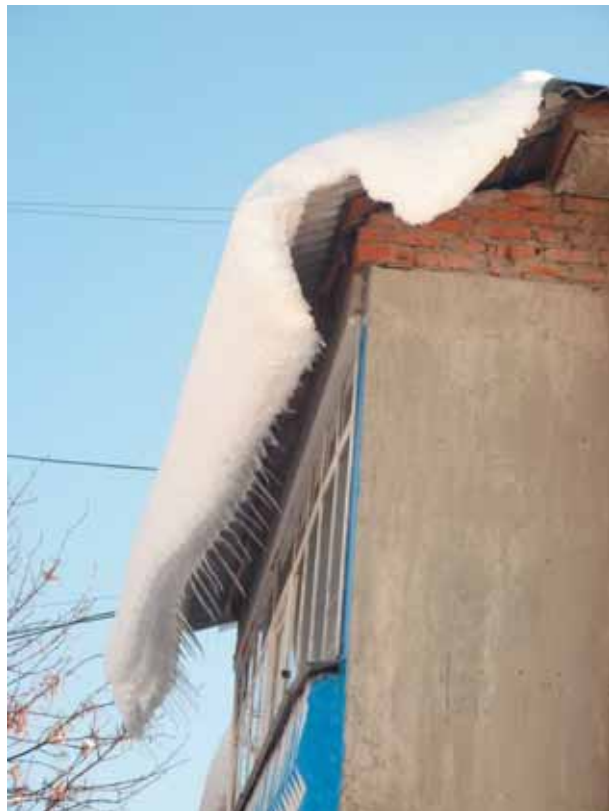
Рис. 4. Кровля этого дома совсем «свежая» — сделана летом. Снега зимой было мало, поэтому чрезмерно большой свес шиферной кровли пока еще держит сползающий снеговой мешок. Но что будет лет через 5–10, когда шифер состарится или снега выпадет больше?
