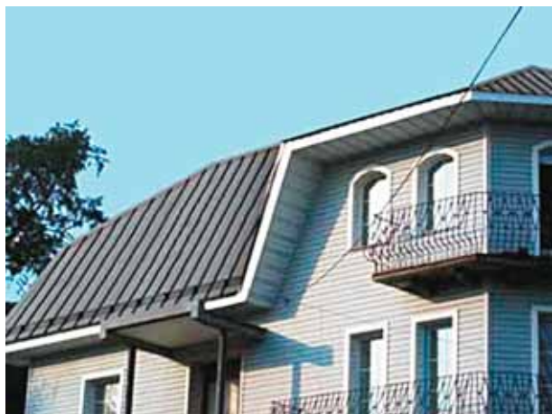
фальцевая кровля (металлическая)
